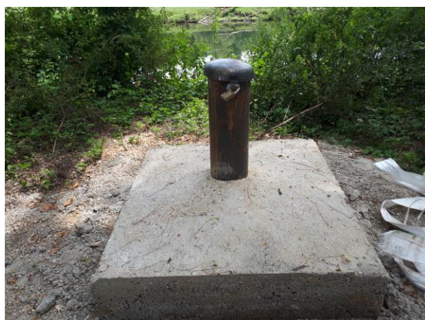
Piézomètre aux alluvions de l'Eure
